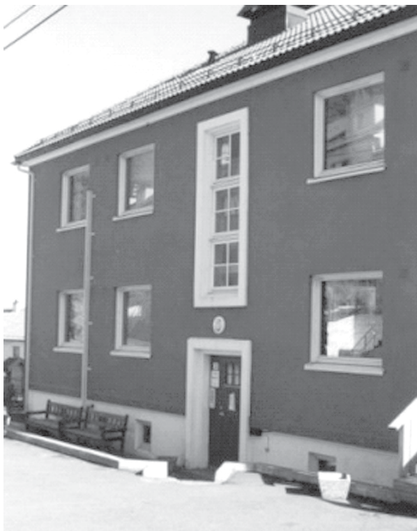
10. kép Újonnan épült közösségi ház Saksarhaugenben (Bergen, Norvégia)
